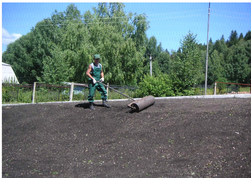
Прикатывание почвы после посева гладким водоналивным катком
